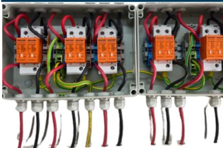
Um die Folgen eines Blitzschlags an der Anlage, am Gebäude oder in der Nähe zu verringern, schreibt das Gesetz seit 2018 einen angemessenen Überspannungsschutz für Photovoltaik-Anlagen vor.
